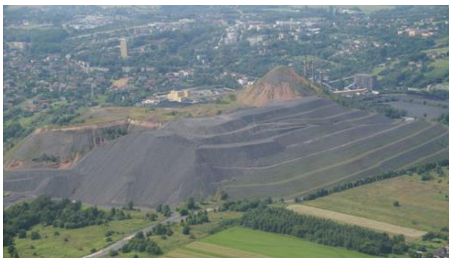
Fot. 4. Widok na obiekt od strony wschodniej. Źródło: mat. kopalni Phot. 4. View of the structure form the east. Source: main materials
