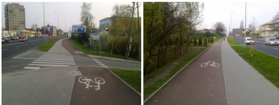
Fot. 1-2. Ścieżka rowerowa N2 z czerwonego asfaltu, ul. Sulechowska Phot. 1-2. N2 bicycle path made of the red asphalt, Sulechowska St.
